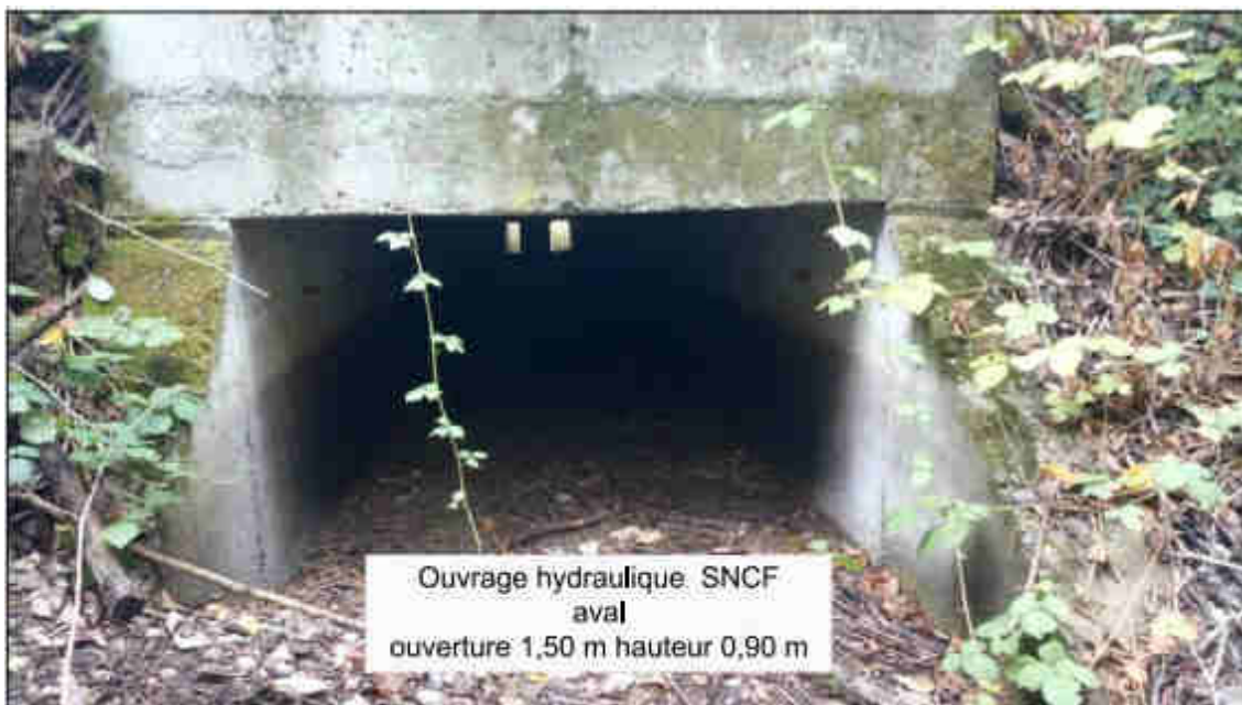
Vue de l'ouvrage hydraulique SNCF depuis le Sud.
