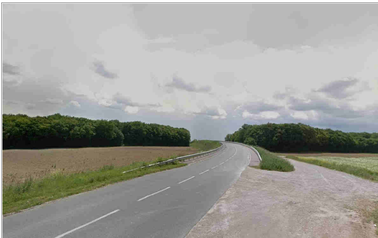
Vue du pont de la RD 96 (Commune de MONTIERCHAUME) franchissant la voie ferrée à 1,7 km à l'Ouest du futur ouvrage.
