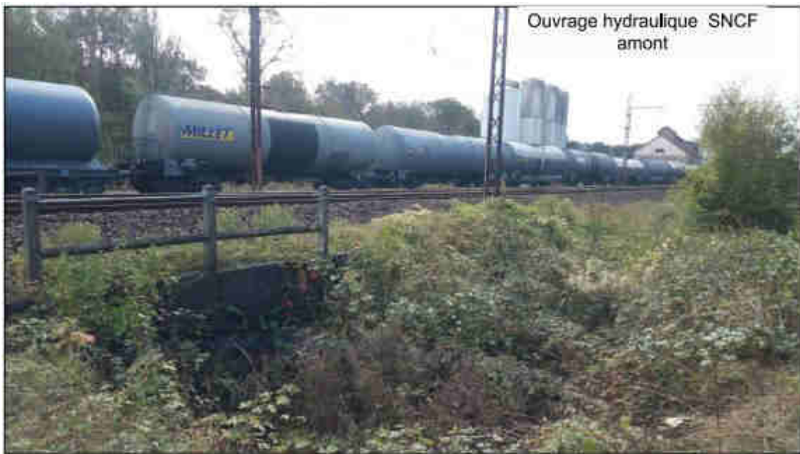
Vue de l'ouvrage hydraulique SNCF depuis le Nord.
