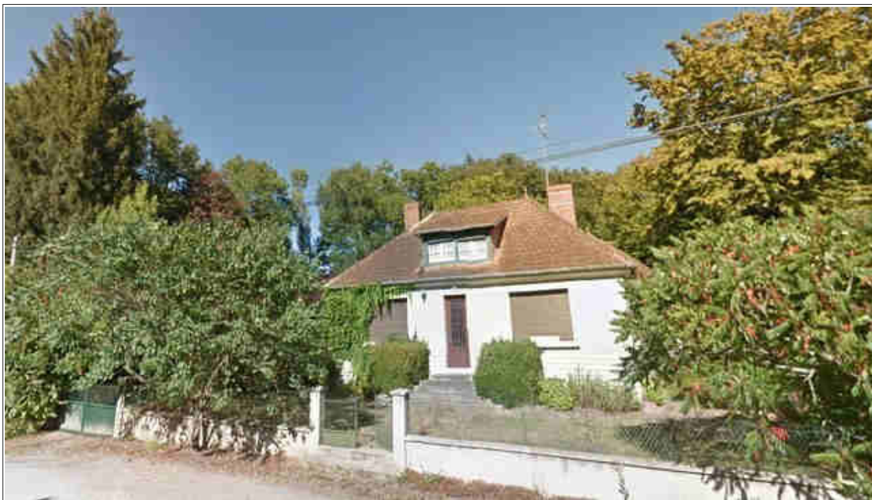
Maison d'habitation à détruire acquise par le Département courant 2018
