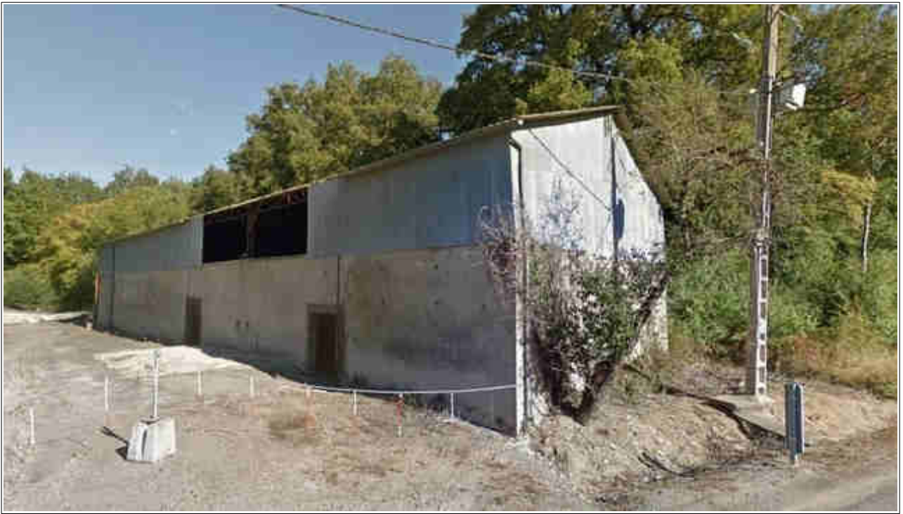
Bâtiment d'AXÉRÉAL désaffecté n°1 à détruire
